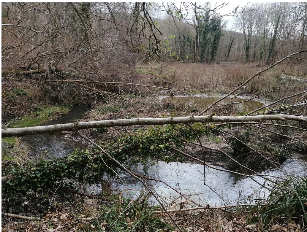
Figure 7 : Visite des travaux de restauration de la Mérantaise avec la création d'une mare.
