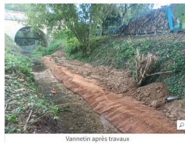
Vannetin après travaux
