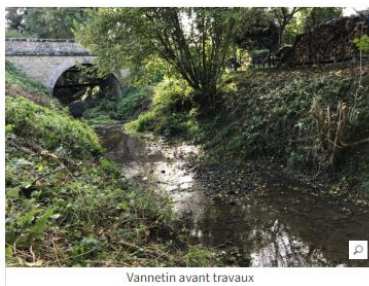
Vannetin avant travaux
